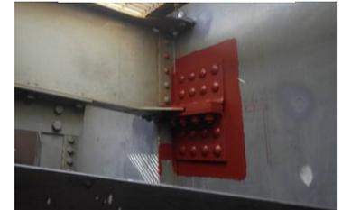
図-6 当て板補強施工後写真
