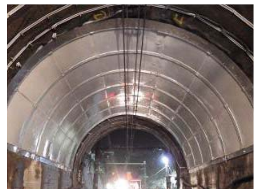
写真-3 補修完了
