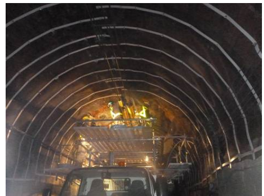
写真-1 レンガ面の養生（樹脂ネット）
