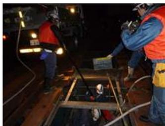
写真-3 PC鋼棒挿入状況
