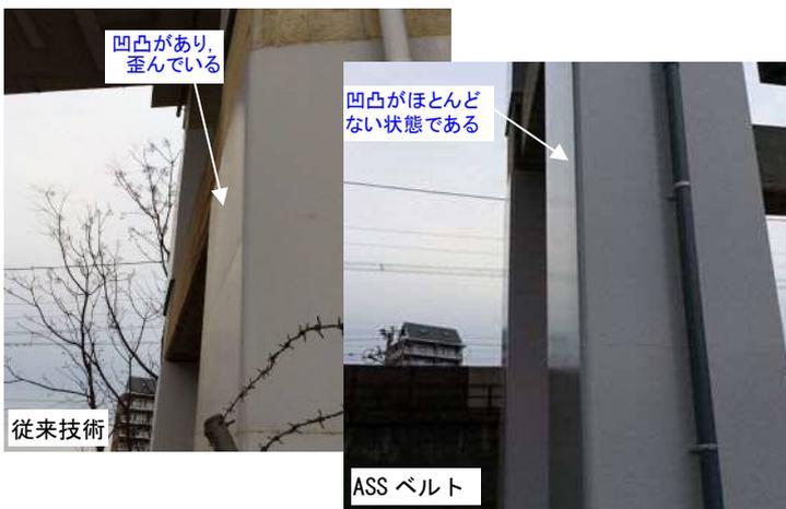
写真-5 従来技術と ASS ベルトの施工後の鋼板表面状況の違い
