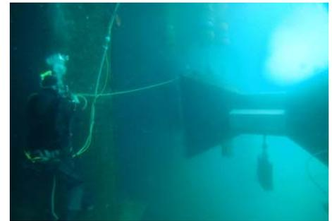
図-8 既設杭への引込作業
