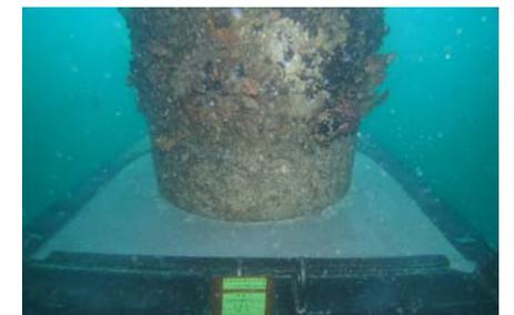
図-6 水中不分離性モルタル打設 (40N/mm<sup>2</sup>)
