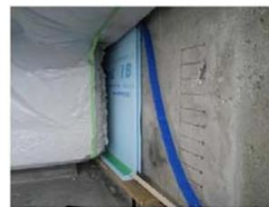
写真-8 型枠設置状況
