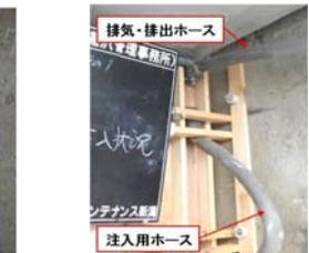
写真-9 断面修復材注入状況
