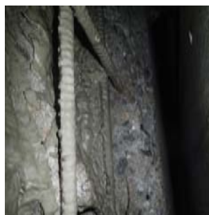
写真-5 防錆剤塗布
