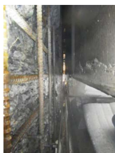
写真-4 はつり状況
