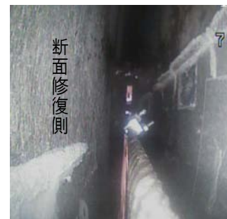
写真-6 断面修復完了
