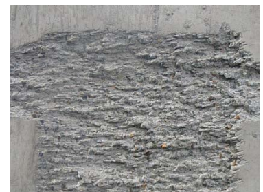
写真-1 試験体のはつり状況(ノズル角度30°)
