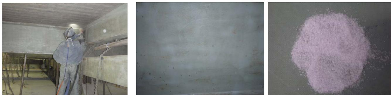
写真-3 重曹ブラスト施工状況(左)・素地調整完了(中)・重曹(粒径 200 μm) (右)
