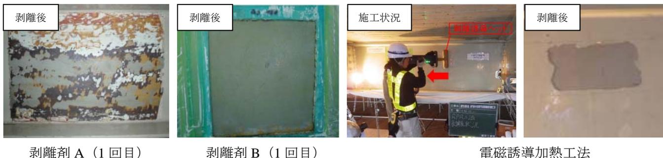
写真-2 各提案工法による塗膜剥離状況
