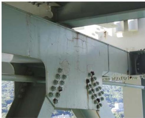
写真-1 補剛桁の塗装劣化状況
