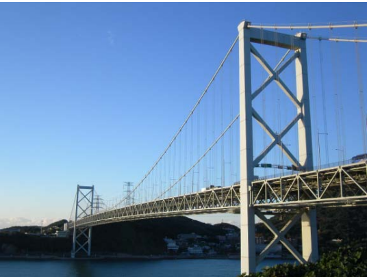
写真-1 関門橋全景
