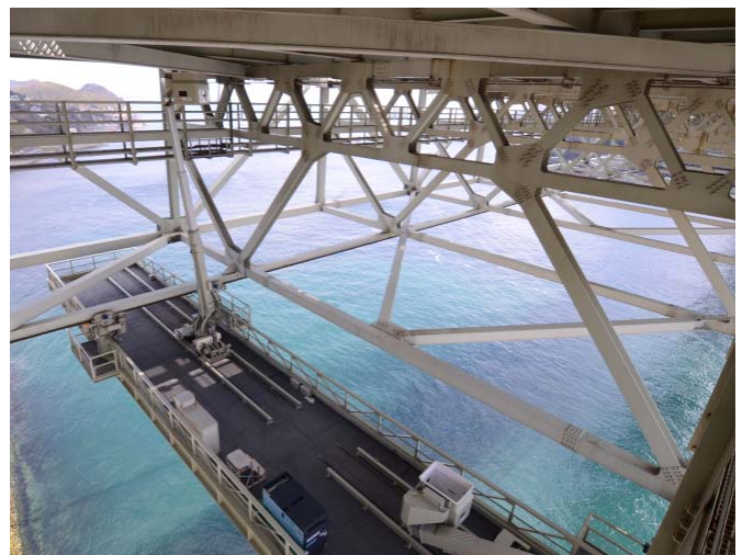
写真-3 第3世代検査車全景
