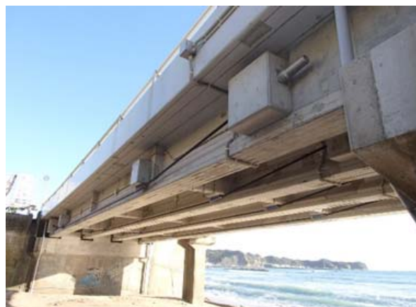
写真-2 外ケーブル補強状況
