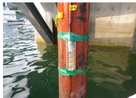
写真-3 電気比抵抗センサ取付状況
