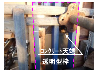
写真-2 コンクリートの充填状況
