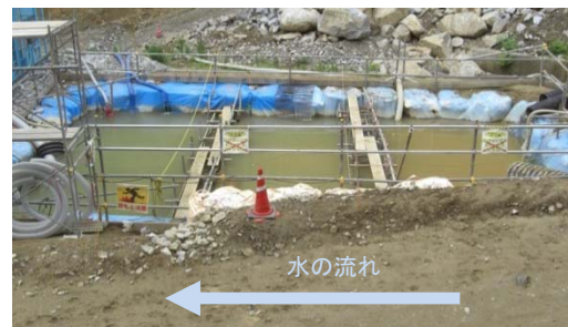
写真2 固形凝集剤設置後の様子
