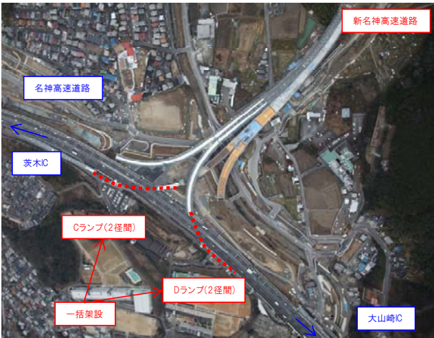
図-2. 橋梁架設位置
