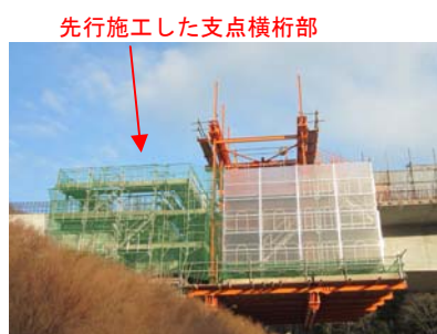
写真-3 足場の転用・結合 (STEP2)
