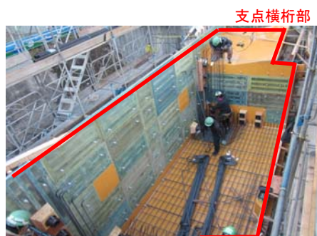
写真-2 支点横桁部の先行施工 (STEP1)
