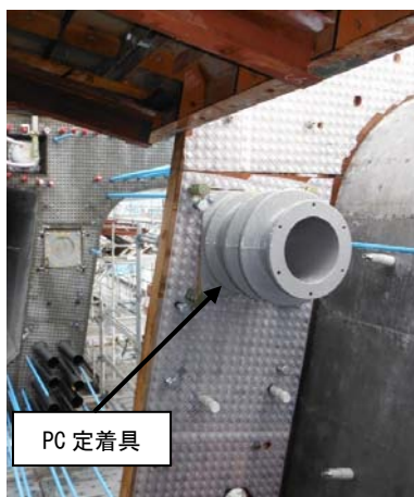
写真-1 補強用 PC 定着具
