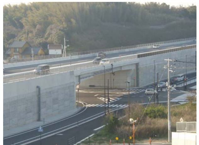
写真-2 開通時全景
