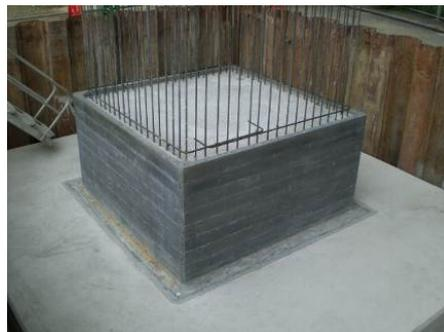
写真-3 躯体コンクリートの打設完了
