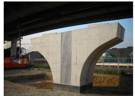
写真-4 橋脚の施工完了
