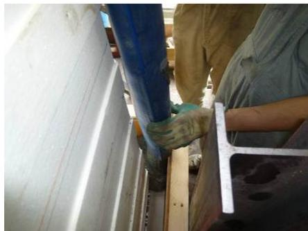
写真-1 UFC の打設状況
