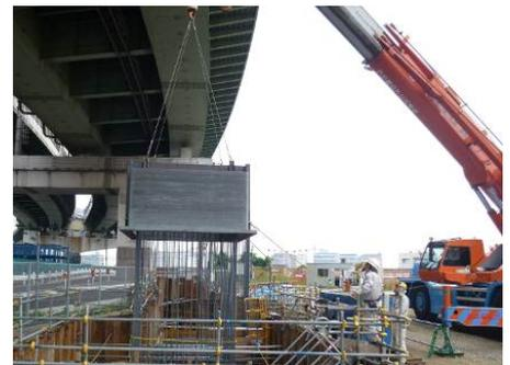
写真-2 PCa 型枠の建込み
