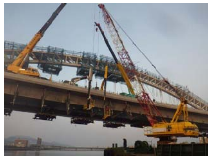
写真-5 架設・調整
