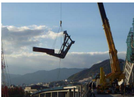
写真-4 地組・吊上げ
