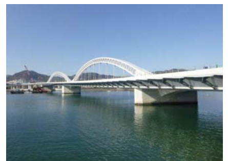
写真-6 施工完了
