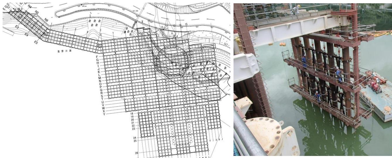
図-2 鹿野川ダム再開発工事仮設構台全体平面図と LIBRA-S 工法による設置状況
