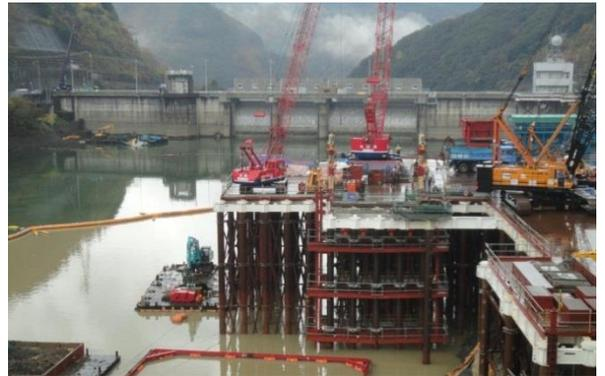
写真-1 ダム湖構台構築作業状況
