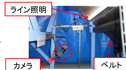
図-2 カメラ取付状態
