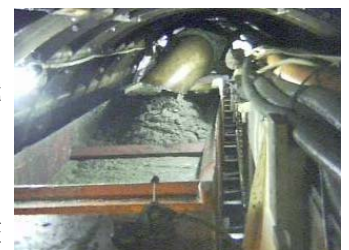
写真-2 新型起泡剤気泡土の排土状況
