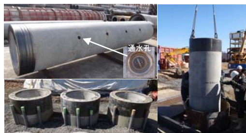
写真-2 試験施工状況
