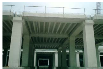
写真-1 大容量雨水貯留施設 (プレキャストコンクリート工法)
