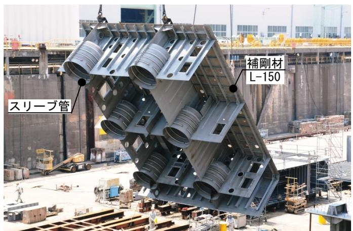
写真-1 ハイブリッドケーソン鋼殻内部
