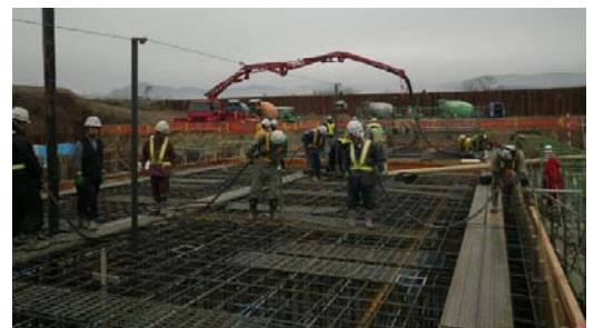
写真1 床版コンクリート打設状況
