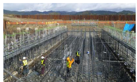
写真3 鉄筋架台設置状況
