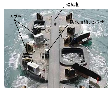
(c) 浮上中の上部鋼管
