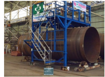
写真-1 サブマージアーク溶接による長尺
