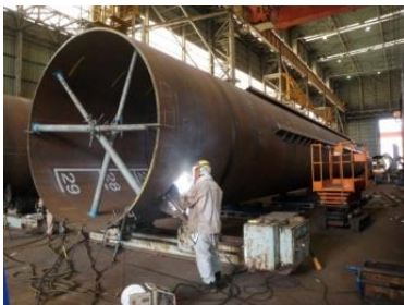
写真-2 鋼管製作
