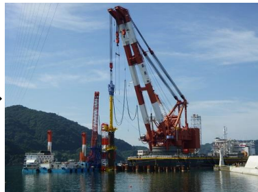
写真-3 下部鋼管打設
