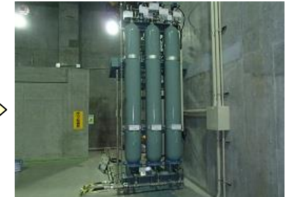
写真-7 蓄圧タンク設置
