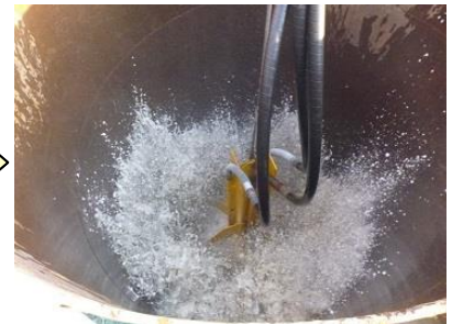
写真-4 中掘・洗浄
