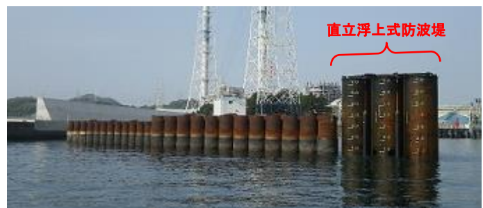
写真-8 浮上完了時の状況
