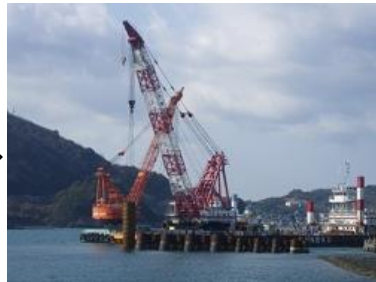
写真-6 上部鋼管挿入
