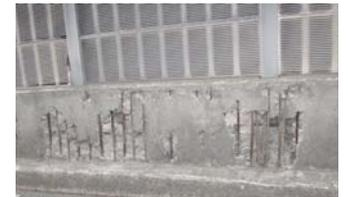
写真-2 壁高欄(上り側)の損傷写真
