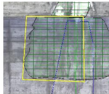
写真-2 変状パターンの例 (ひび割れ+漏水・漏水跡+補修跡)
