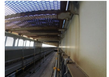
点検装置にて撮影した画像
