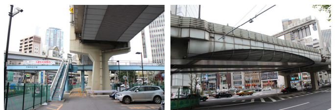
写真-1 美装化対策箇所の状況
