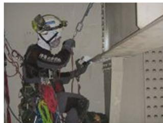
写-5 磁粉探傷試験の実施状況
