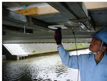
写真4 外部計測器による無線計測
