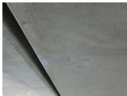
写真5 センサ埋設箇所のコンクリート表面の外観
