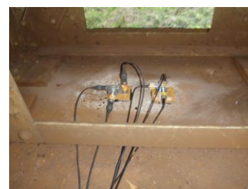
図-3 加速度計設置状況
