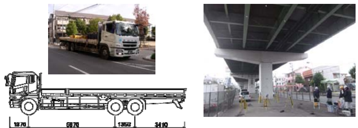
図-1 実橋におけるたわみ計測の状況
