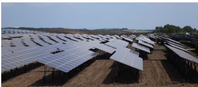
図-9 施工後のアレイの様子
