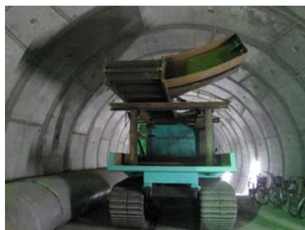
写真-1 補強リング運搬状況
