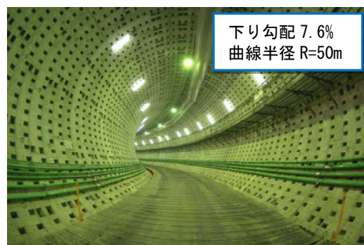
写真-1 坑内状況
