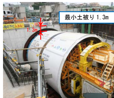
写真-2 シールド発進前状況
