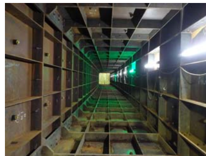
写真-2 掘進完了後の坑内
