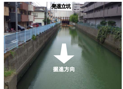
写真-1 スパイラル区間全景
