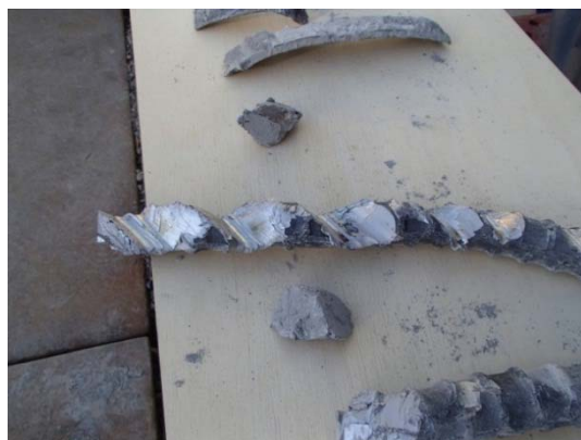
写真-2 鉄筋切断片
