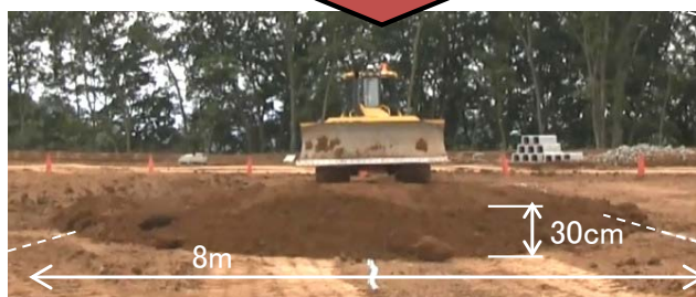
図6 自動走行による撒出し結果
