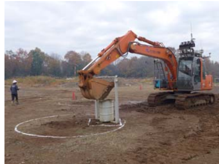
写真-2 作業状況
