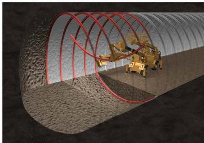
図-1 インバートストラット組立施工イメージ
