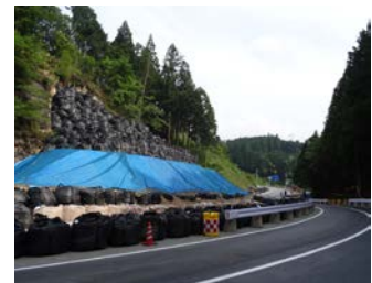
写真7 復旧完了直後
