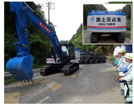
写真3 遠隔操作式油圧ショベル （近畿地方整備局より貸与）
