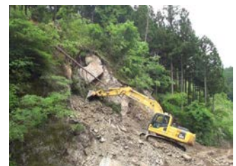
写真5 浮石除去状況
