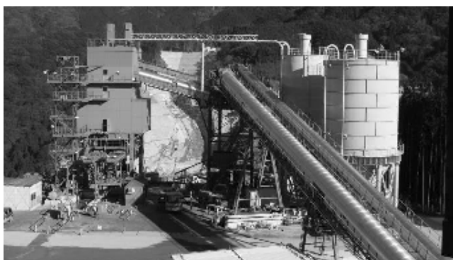
写真-1 ロープロBP全景
