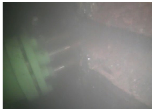
図-5 施工状況（水中写真）
