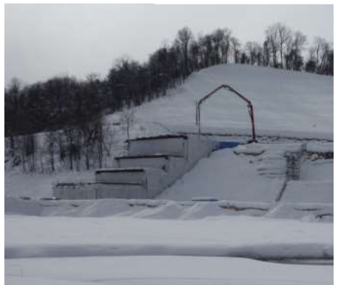
写真-3 取水設備の雪寒仮囲い全景
