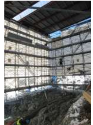
写真-2 雪寒仮囲いの内部
