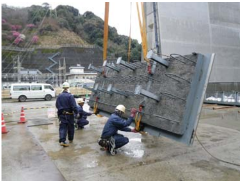
写真-3 コンクリートを打ち込んだ整流板を反転する状況
