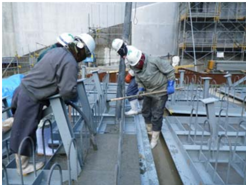
写真-2 整流板の背面へのコンクリート打込み状況
