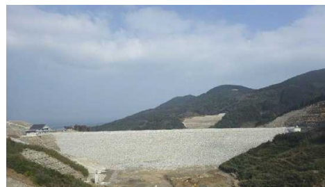
写真-2 盛り立てが完了した荒瀬ダム
