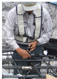
写真-1 鉄筋計設置状況
